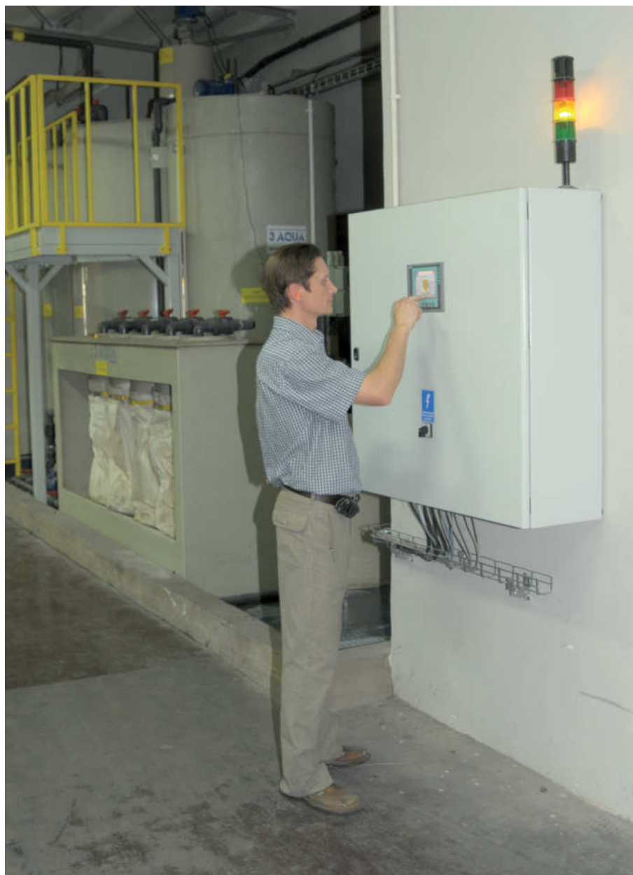
Старший мастер малярного цеха пневматики и гидравлики Яцек Григуч в процессе запуска очистной станции сточных вод процесса нейтрализации в автоматическом режиме
